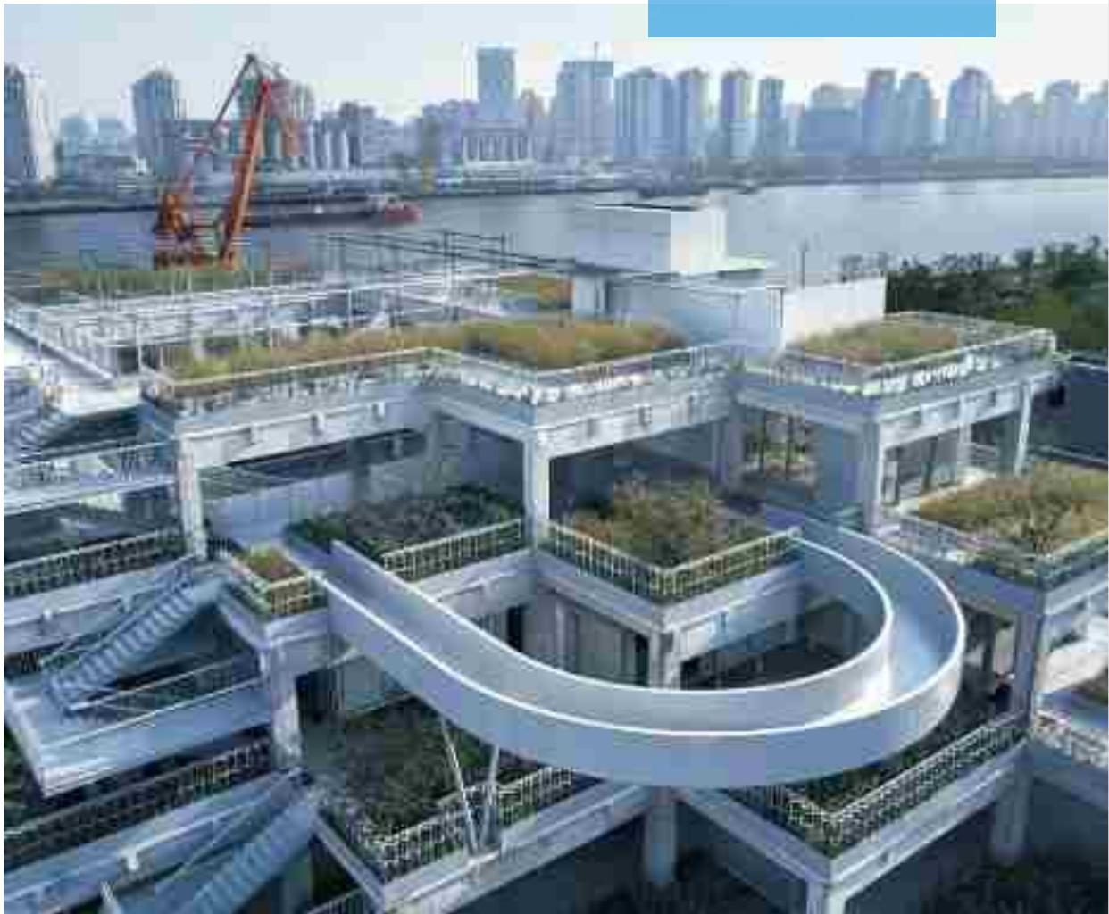
作为一个改造项目，绿之丘只继承了废弃烟草仓库的结构体系。设计有着清晰的逻辑。建筑本身作为连接城市和江岸的桥梁，通过挖洞跨越城市道路；为削弱建筑大体量的压迫感，以退台的方式在两个方向上层层下降。
