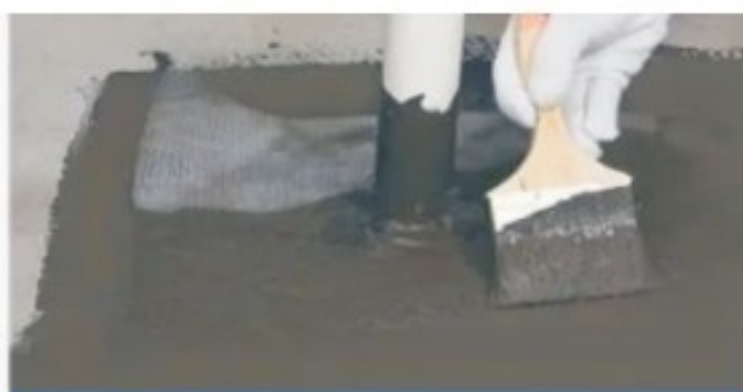
2. 管道阴阳角加强处理
